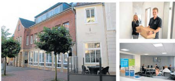
Blick auf die Firmenbasis der „ITM Gruppe“. Am 1. September zog das Unternehmen in die Hauptstraße 43 und befindet sich somit jetzt mitten in der Innenstadt von Gescher.
